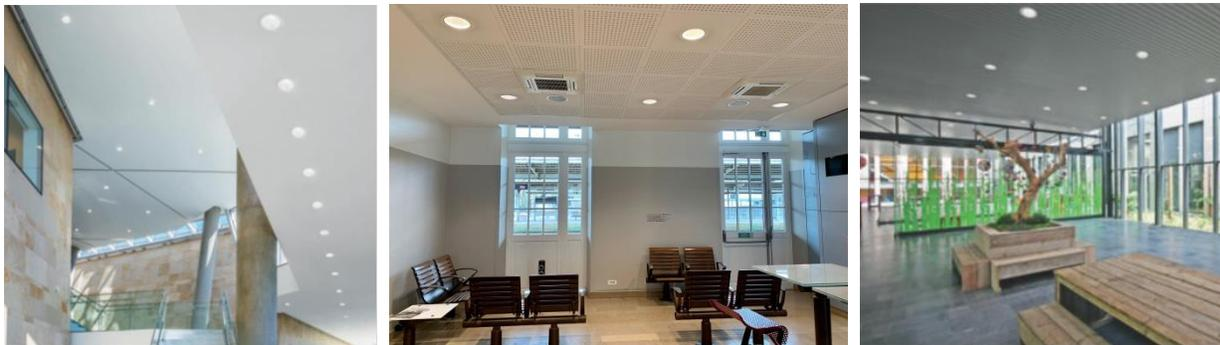
Compatible avec le système intelligent de gestion Digital Lumens (division du groupe Osram), le plafonnier LED BAKU peut-être également connecté. Il communique alors via le maillage radio des luminaires et constitue un réseau indépendant et parallèle qui ne perturbe pas les réseaux en place. Contrôlé le plus souvent par zone d'activité, l'éclairage passe ainsi automatiquement du niveau d'éclairage le plus bas en l'absence d'occupation au niveau d'éclairage maximum en pleine activité.
