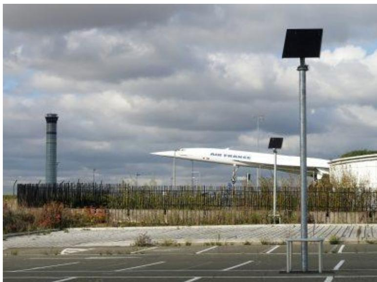
EAS Solutions s'est vu confier l'éclairage solaire du parking du siège ADP de Roissy Charles-de-Gaulle. Après deux années de test sur site, 18 luminaires LED LUMAZ SOLAIRE ont été installés sur le parking. Ils ont permis d'économiser plus de 3940 kWh d'électricité par an et, ne nécessitant ni raccordement au réseau ni maintenance, ont considérablement réduit les coûts d'exploitation liés à l'éclairage du parking.
